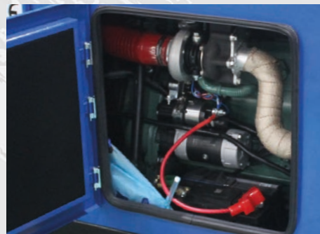
Vano manutenzione interna
