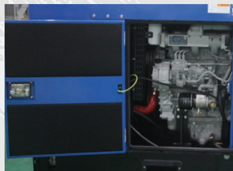
Vano manutenzione interna
