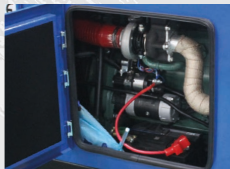
Vano manutenzione interna
