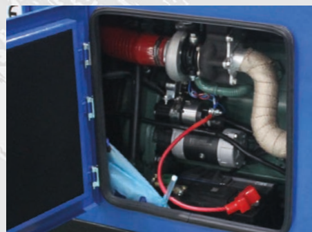
Vano manutenzione interna
